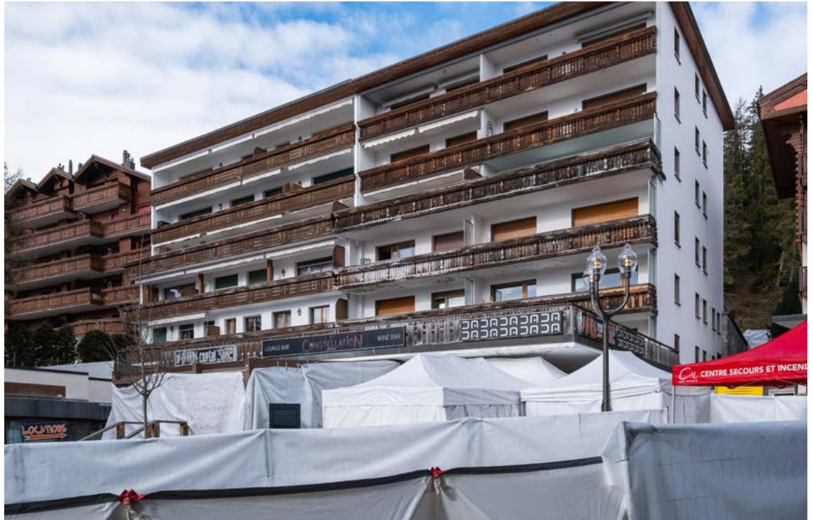
Abb. 1: Das Gebäude der Bar „Le Constellation“ in Crans-Montana, Schweiz, am 2. Januar 2026, einen Tag nach dem Brand.
